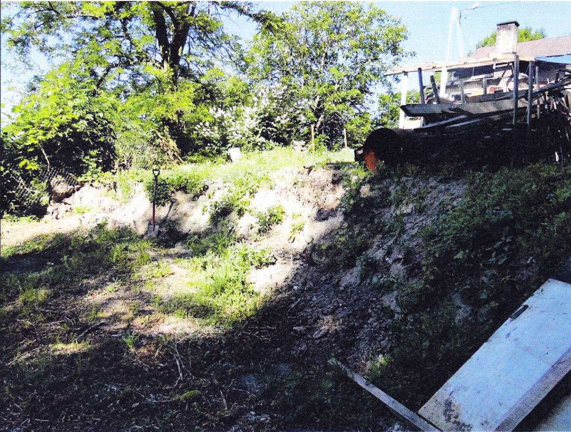
Aktywna część osuwiska - skarpy w okolicy uszkodzonych budynków
